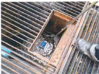
จุดที่ 7 บริเวณบ่อพักน้ำสุดท้ายพร้อมตะแกรงคัดขยะ
